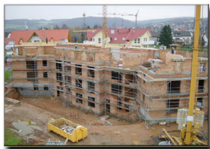
Hoch- und Tiefbau - Stahlbetonbau
